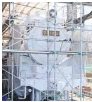
▲1回目のさび止め
