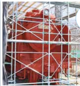
▲2回目のさび止め
