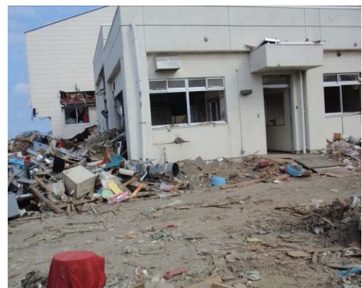
津波により1階校舎の前は瓦礫の山
