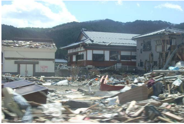
国道45号付近から見た堅牢な建物の外観はしっかりしているが津波により窓等はなく周辺は瓦礫の山である
