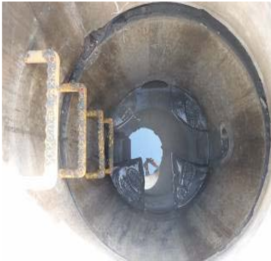
写真 3, 4 マンホール内の被害状況
