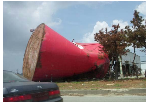
津波に押し倒されたタンク
