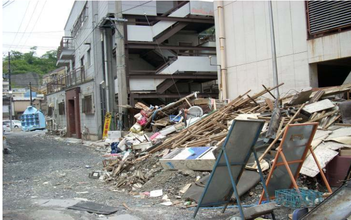
マンション付近の路地裏の瓦礫
