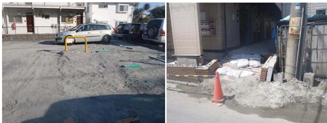
写真 9,10 液状化による土砂
