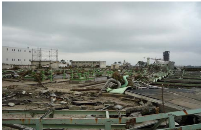
汚水受入施設などの設備やパイプラインが破壊されました 〈仙台市建設局経営企画課のホームページより〉
