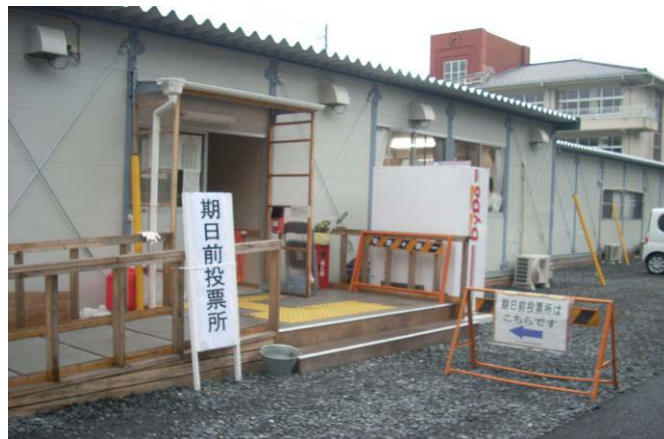
小原木中学校仮設住宅集会所（後方は小原木中学校校舎）
