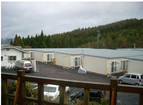
テニスコート段上の休憩所から見た仮設住宅
