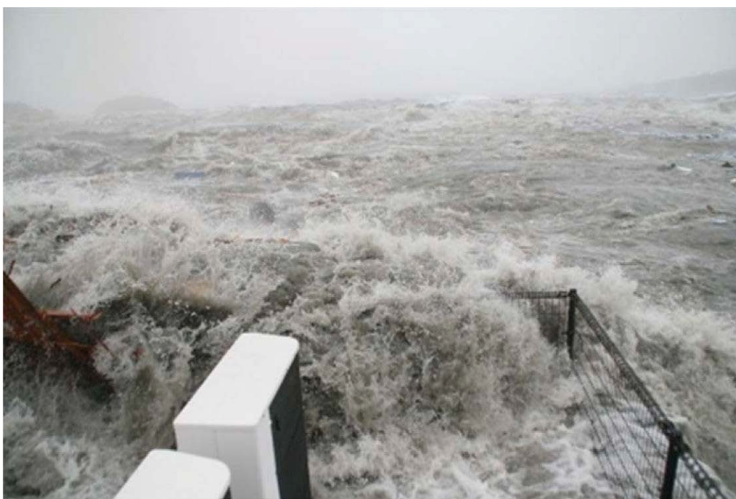
【防災対策庁舎屋上から南東方向を撮影】波が来ている向こうの柵の下に、2階建の本庁舎があった。津波は、この屋上を海面の高さが一緒になった瞬間であるが、このあと、さらに2mほど上まで到達したと思われる。
