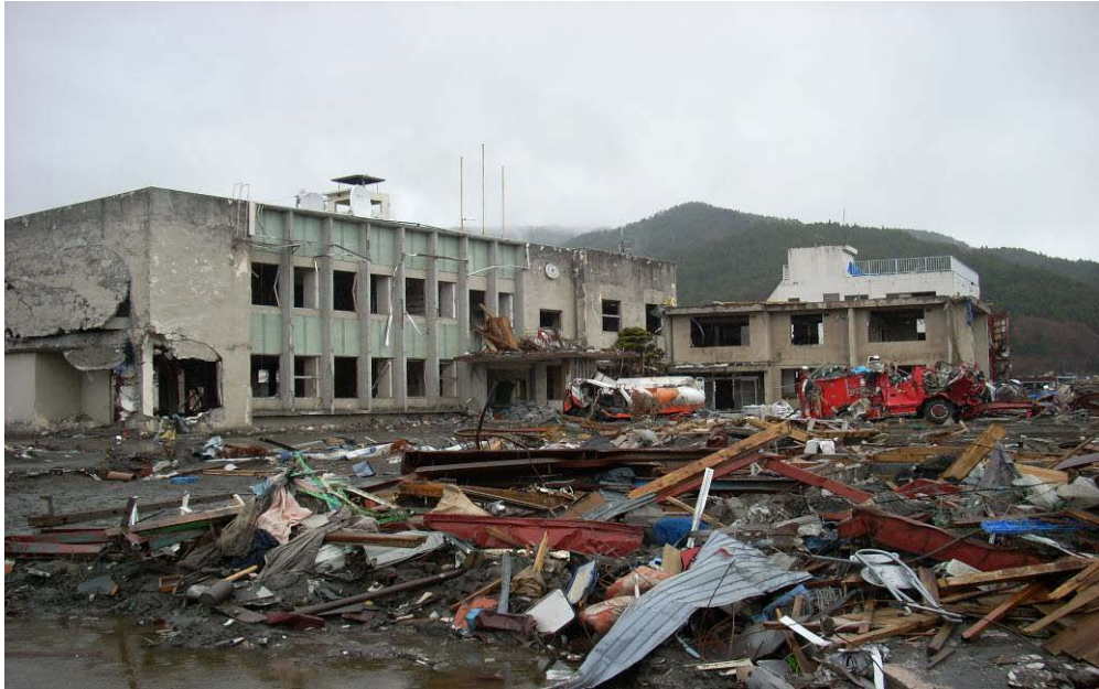
（津波で崩壊した大槌町役場）
