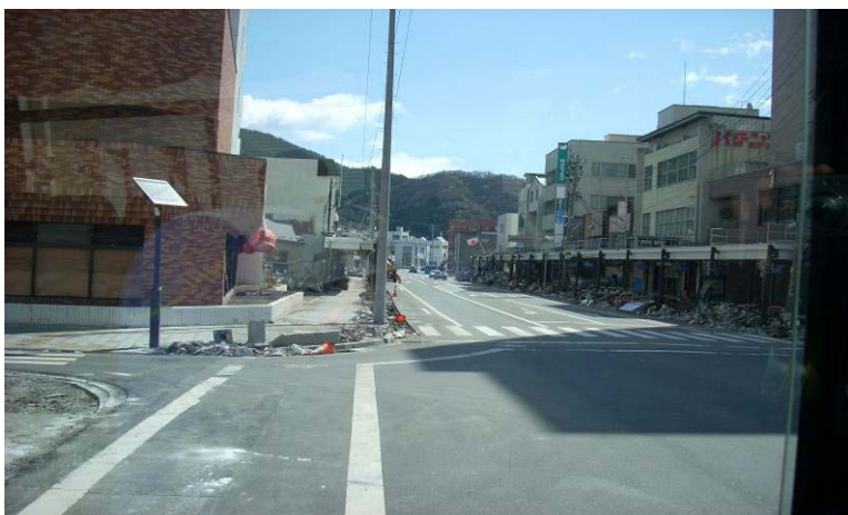
県道4号線・大町交差点より東方向 (商店街側には瓦礫が残っている)
