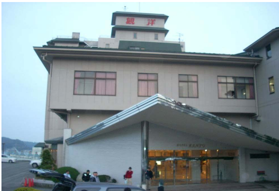
高台に建つ宿泊施設と2次避難所となっている「ホテル観洋」
