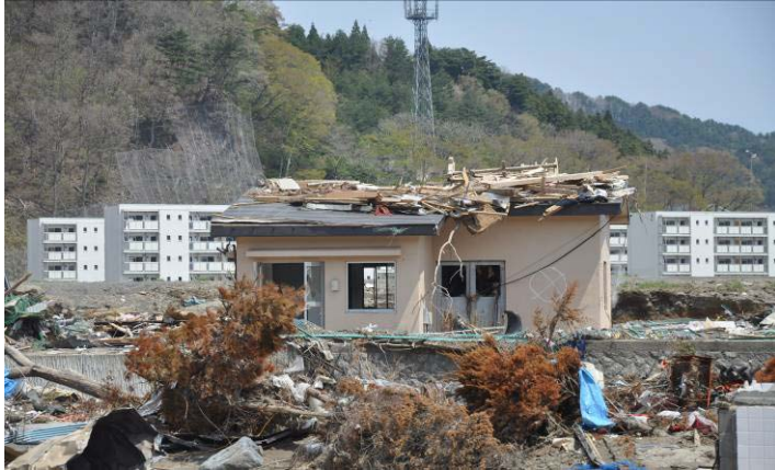
鵜住居地区の後ろのアパートの3階部分まで水が上がったので、手前の家の屋根には瓦礫がのっている。
