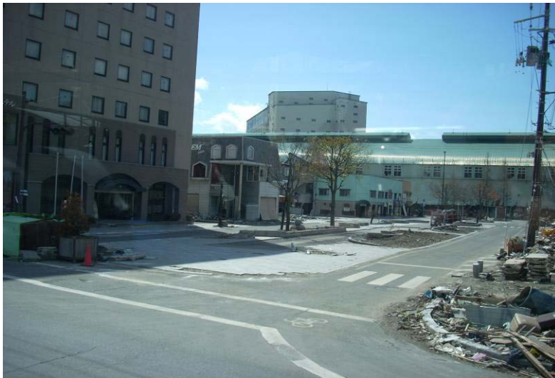
左側：釜石ベイシティホテル、後方の細長い建物は、鋼製家具製造のエヌエスオカムラ（株）工場で、その向こう側が釜石湾方面であるので、この建物を突き破って津波が押し寄せた。さらにこの建物の後方が、飼料サイロの釜石グレンセンター（株）
