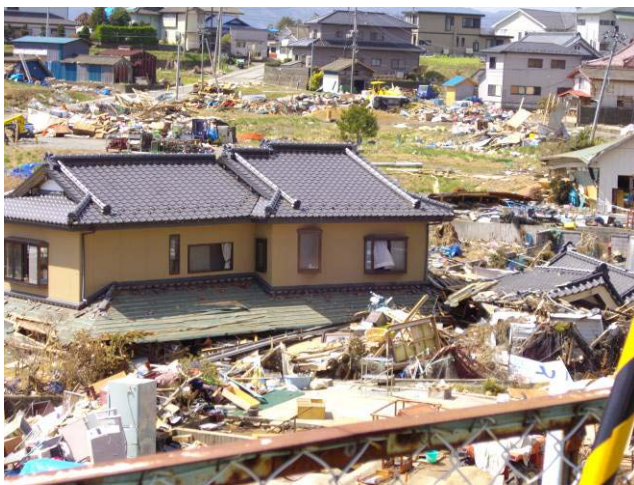
(2階部分のみ残った新築住宅)
