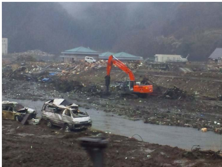
小鋸川 での作業状況
