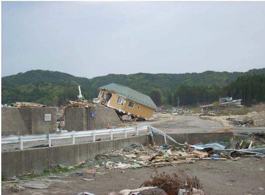
引き波で防潮堤まで持って行かれた家屋（国道45号から見える） （大槌町吉里吉里地区）
