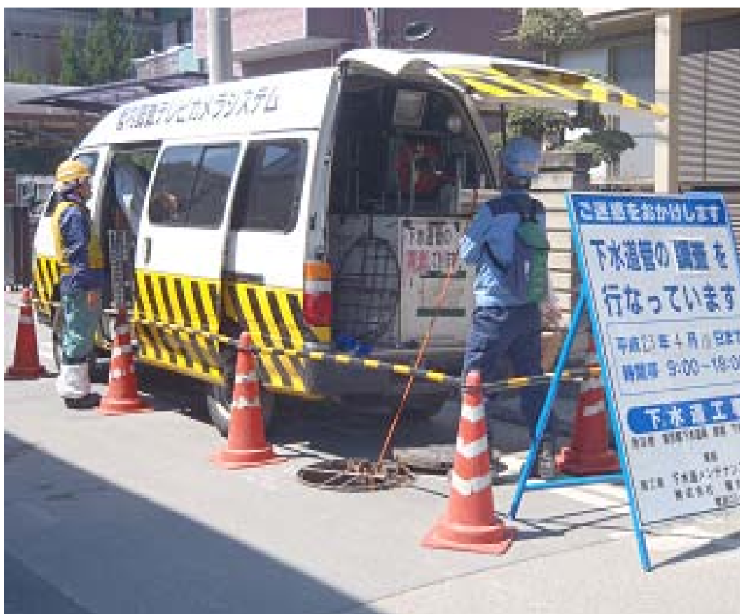
(浦安市における下水道管調査作業)
