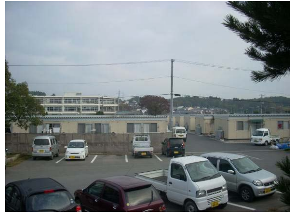
大谷中学校校庭の仮設住宅
