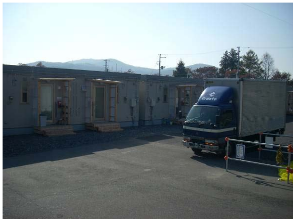
旧折壁小学校仮設住宅
