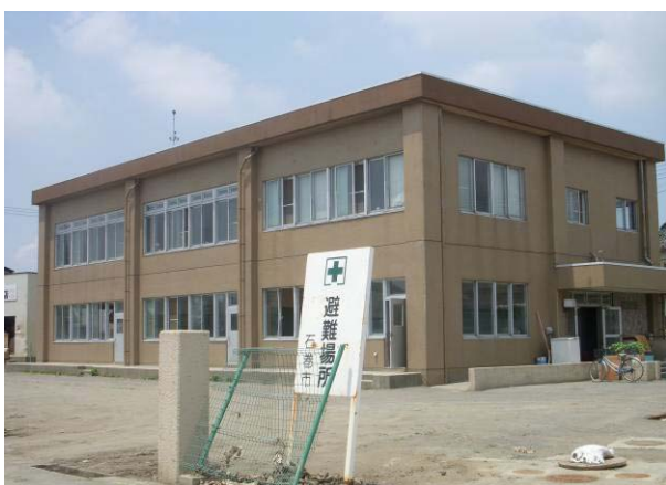
大街道地区の学習等供用施設釜会館の避難所 (周辺も浸水状態が続いていた中で、瓦礫の撤去や1階のヘドロ状態の泥だしした後、使用しているので悪臭と仮設トイレの汲み取りができていないことからハエの被害で劣悪な環境)
