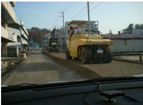
冠水防止の工事（魚市場付近）
