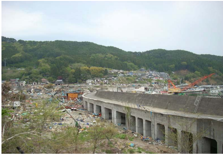
小白浜港の防潮堤付近の様子（南側からの写真）
