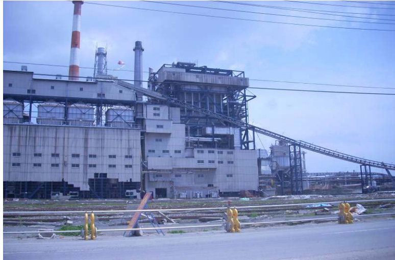
瓦礫撤去後の日本製紙株式会社石巻工場 9月末の操業再開を目指している。
