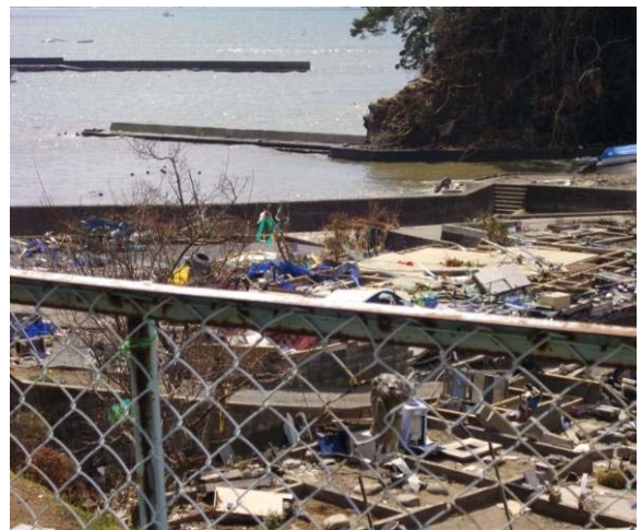
(漁港前の建物は全て流された)
