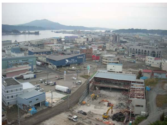
津波の影響で手前「さくらボール」ボーリング場取り壊し（ホテル観洋から気仙沼港を臨む）
