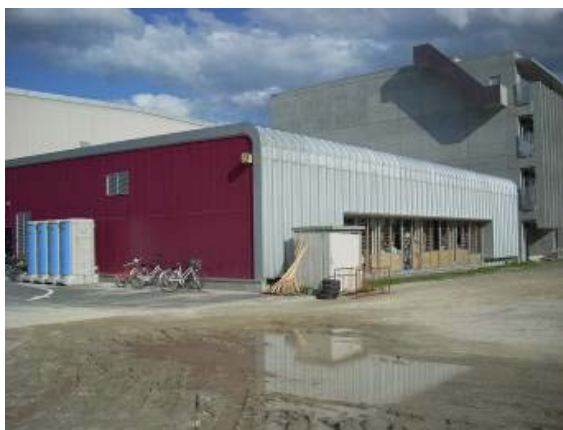
避難所となっている格技道場の外観
