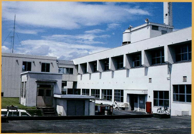
① とうぶはいすいじょう 東部配水場 朝日町四丁目23番28号
