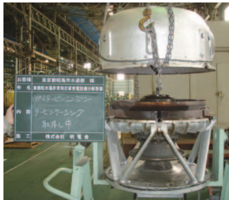
タービンケーシング(外枠) 取外し中
