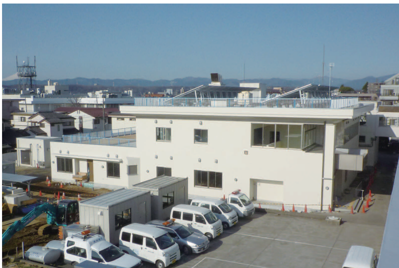
水道部新事務・ポンプ室棟(東部配水場)(2月末撮影)
