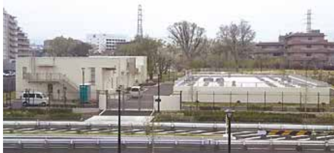
完成した北部配水場
