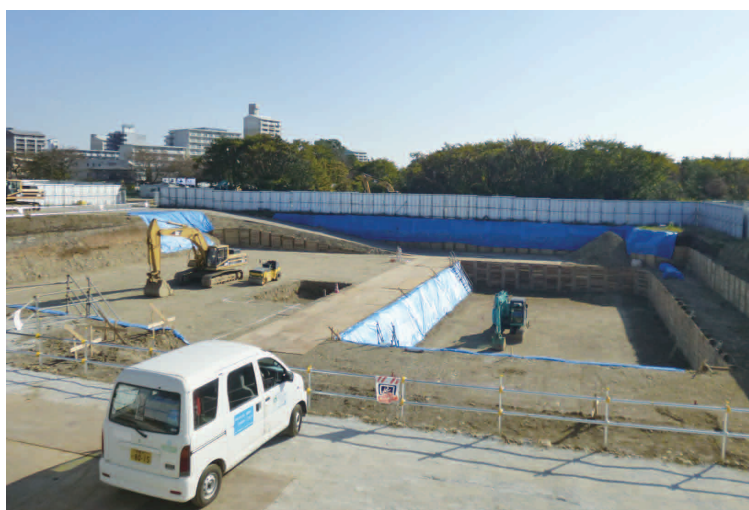
北部配水場工事の様子
