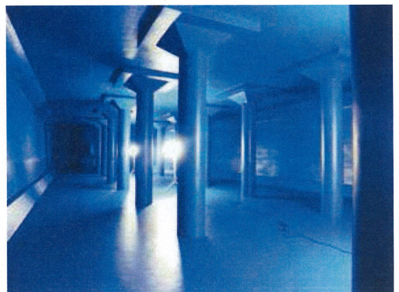
(配水池の中の様子)
