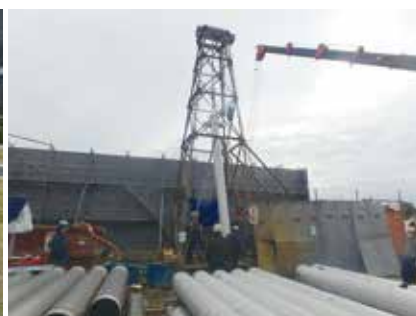
更新(掘替え)工事の様子
