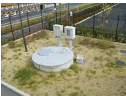
完成した水源井(井戸)
