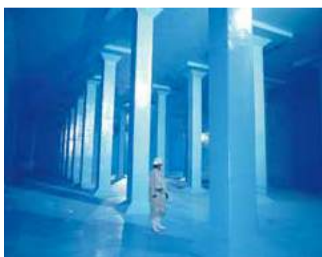
(配水池の中の様子)
