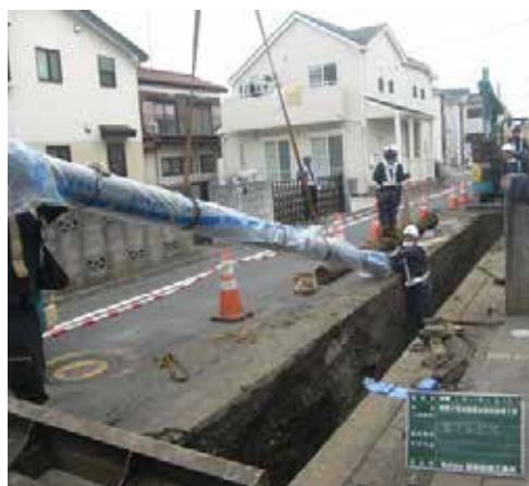
水道管布設工事の様子
