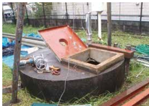
西部6号水源 しゅんせつ工事の様子
