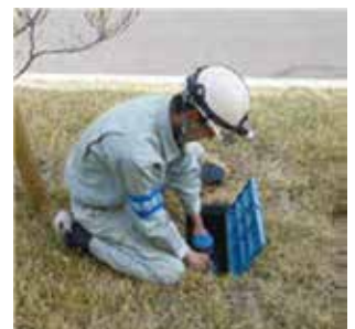
水道メーター取替え作業の様子
