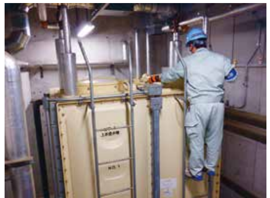
貯水槽水道調査の様子
