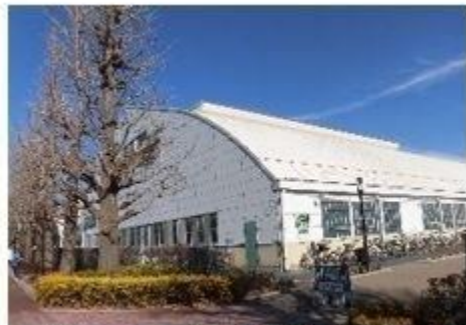
室内テニスコート(昭和飛行機日格納庫)
